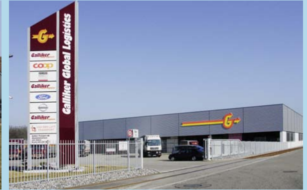
Galliker Logistikzentrum, Möhlin
