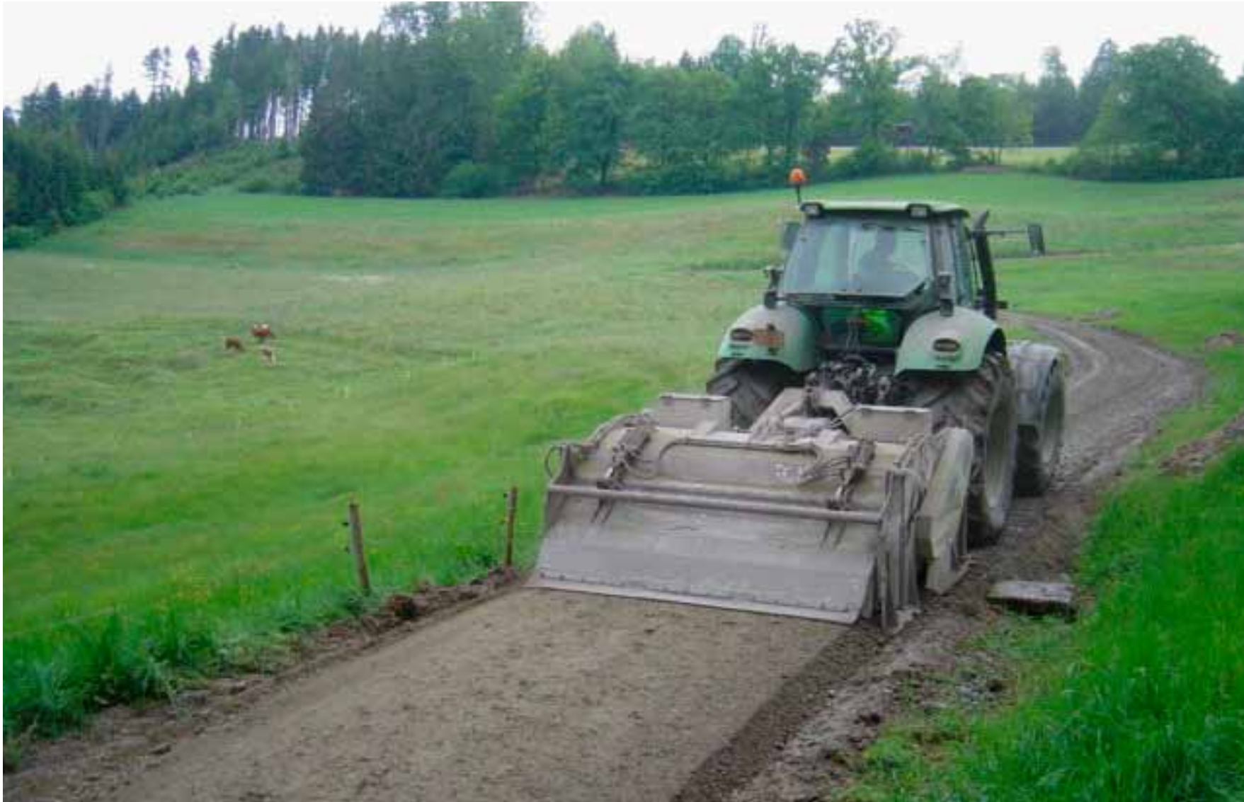
Einsatz der Anbaufräse
