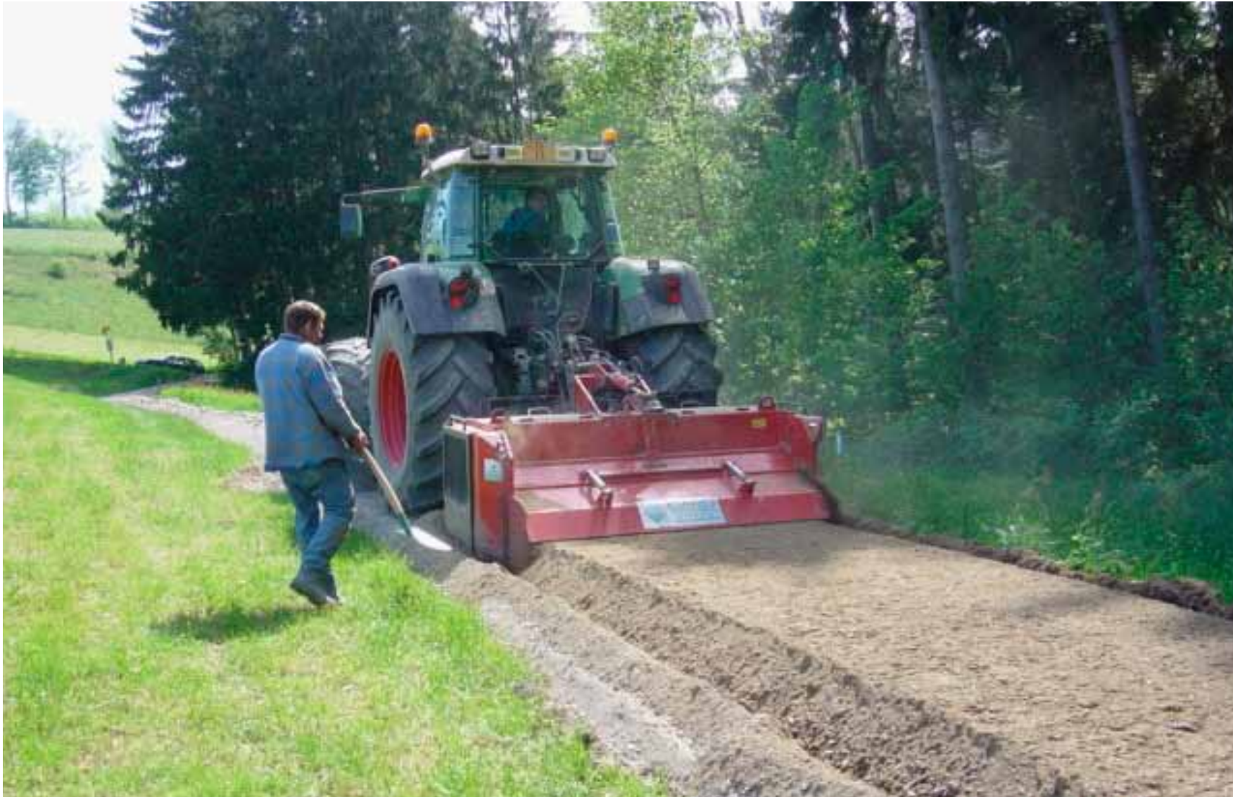
Einsatz der Steinfräse
