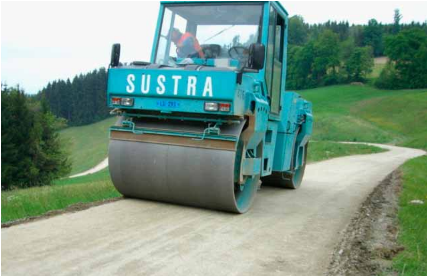
Verdichten des Planums
