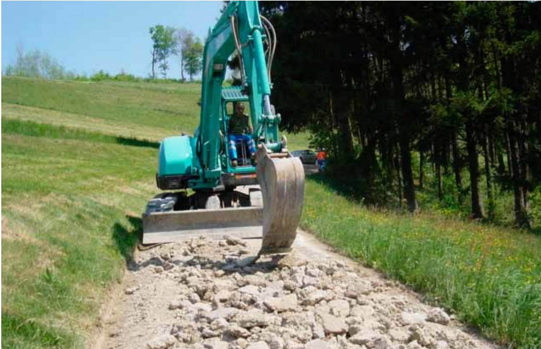
Aufbrechen der alten Fläche
