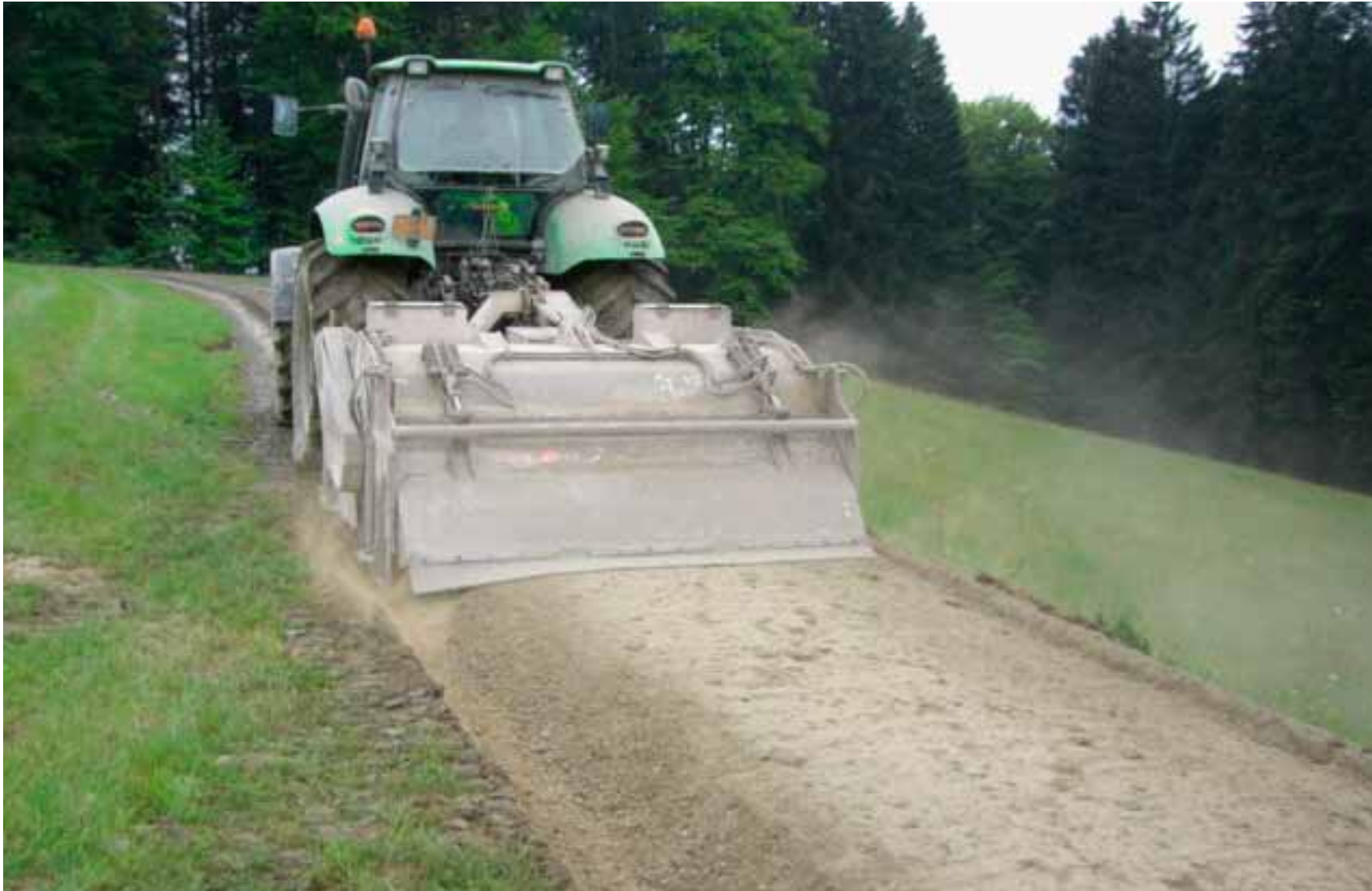
Einfräsen des Zement-/NovoCrete-Gemischs mit der Anbaufräse
