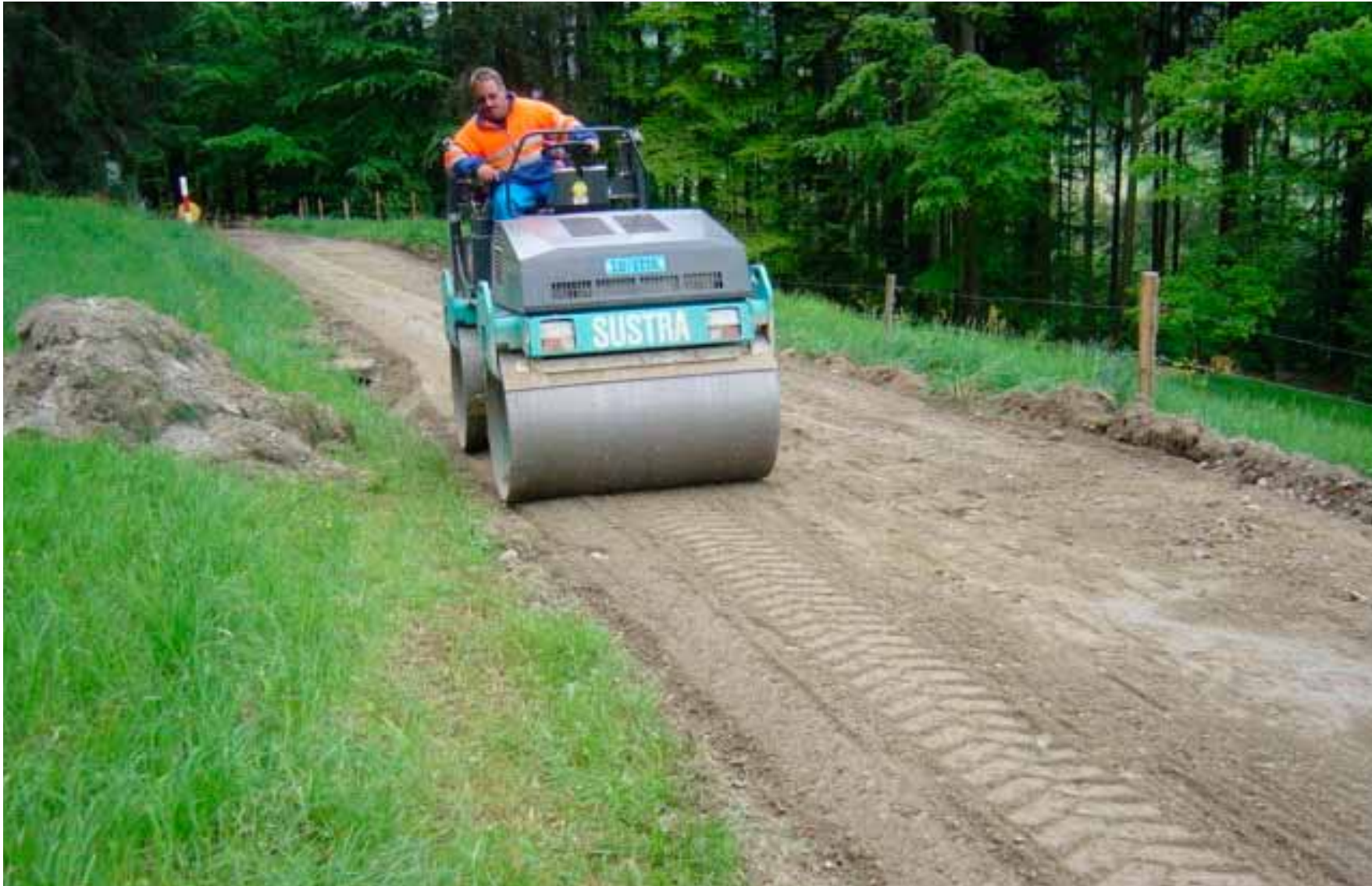
Verdichten des Grobplanums
