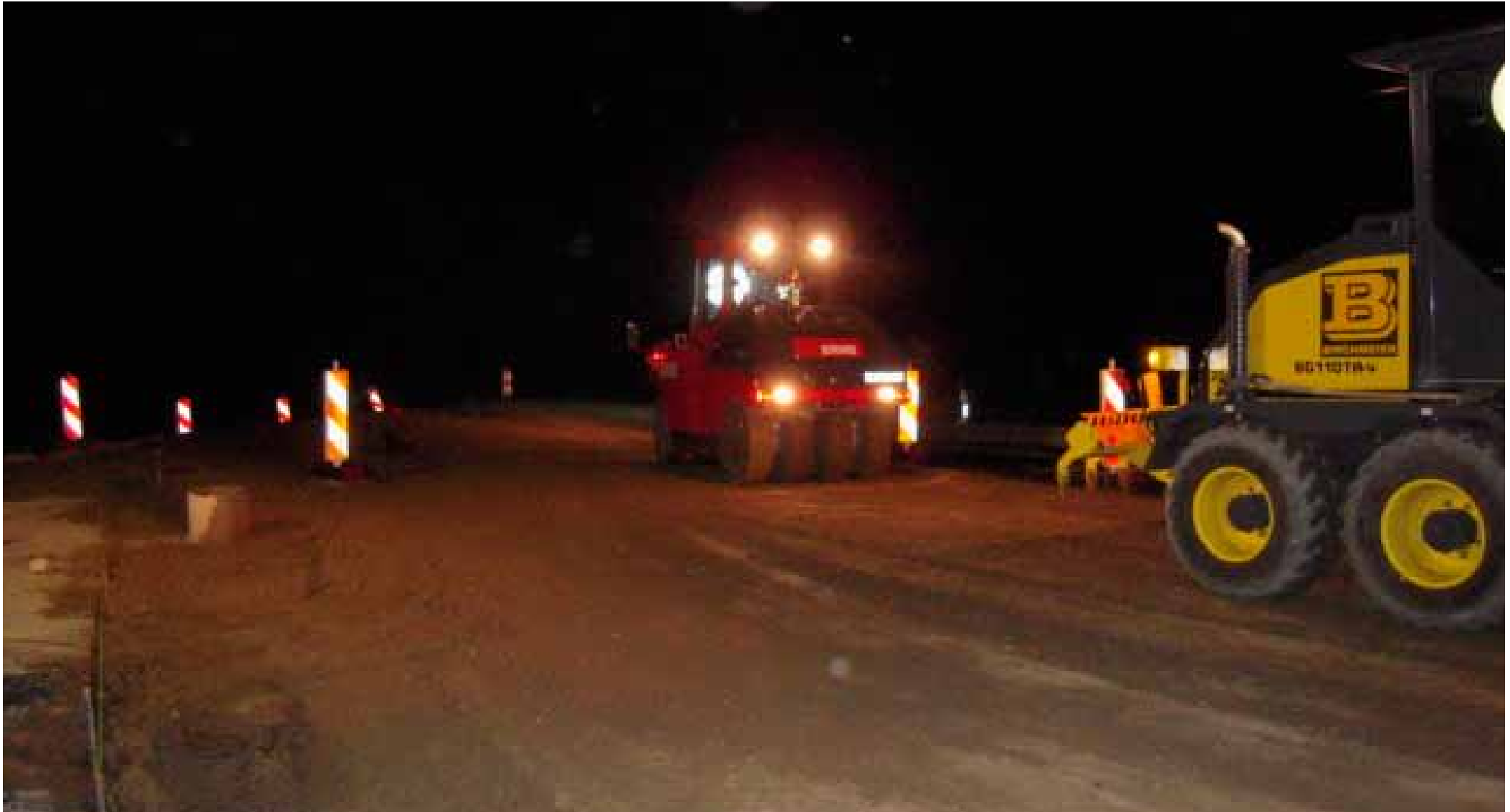
Verdichten der Fläche mit der Gummiradwalze am 25.07.2009
