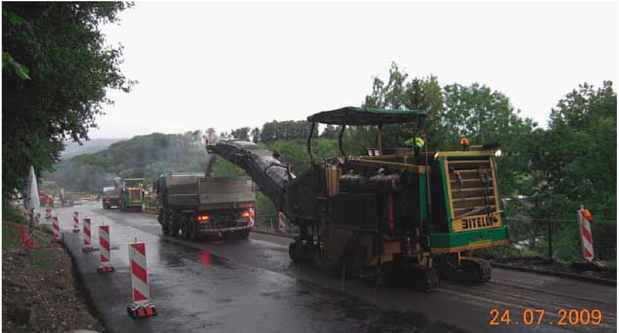
Abfräsen des alten Asphaltbelages am 24.07.2009
