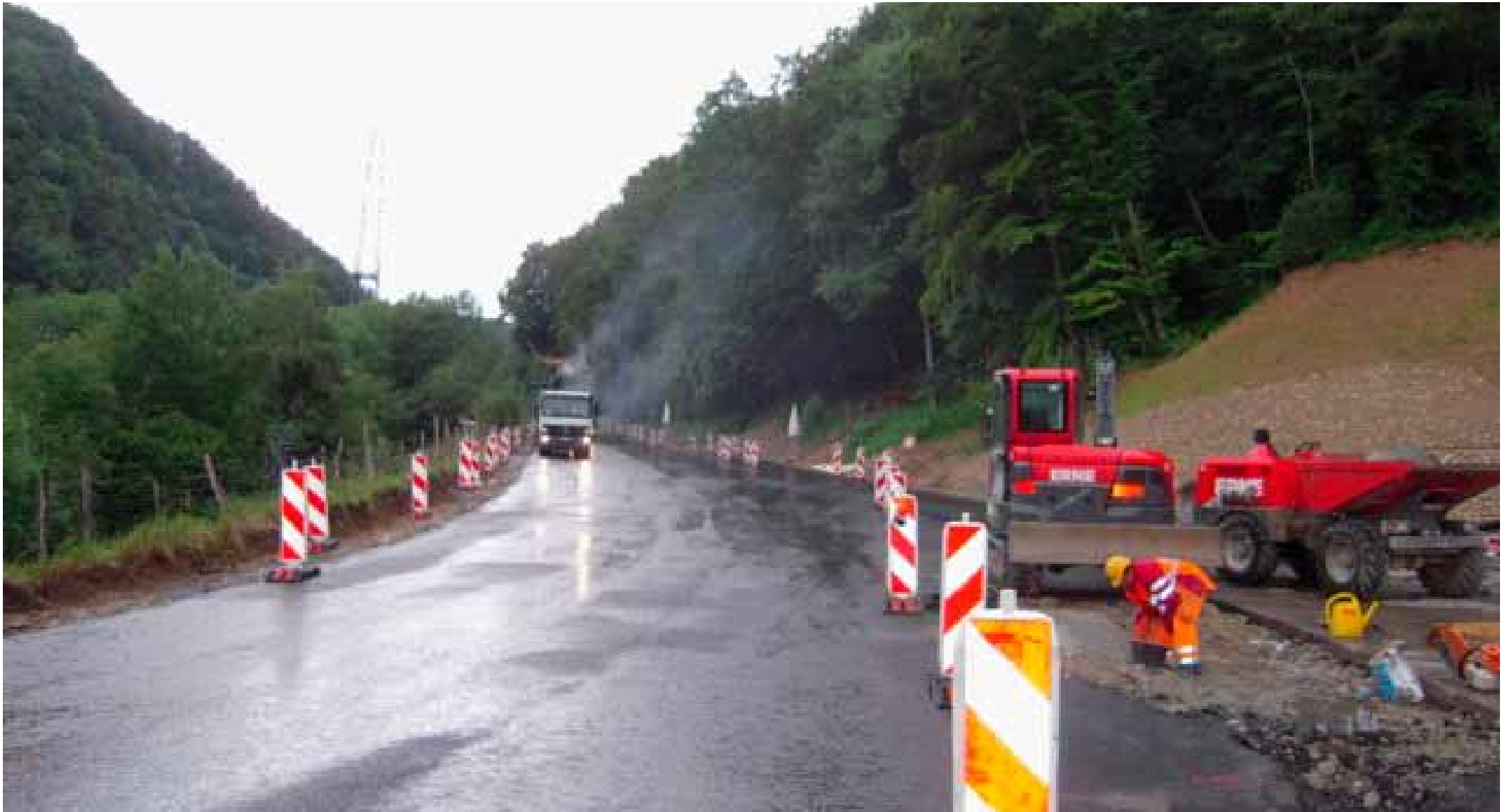
Ausgangssituation (vor dem Abfräsen des alten Asphaltbelages)
