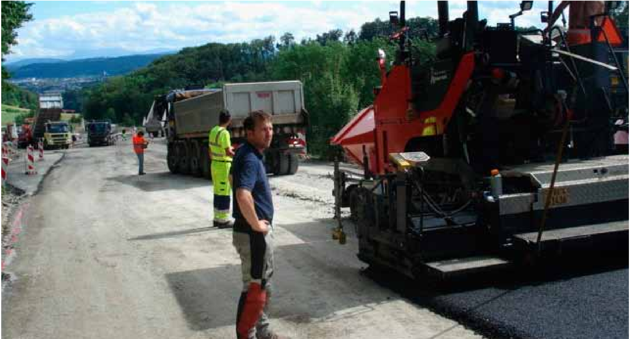
Einbau des neuen Asphaltbelages am 25.07.2009
