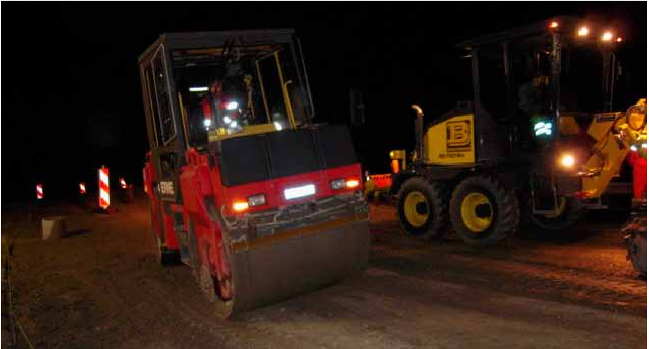
Statische und dynamische Verdichtung der Fläche am 25.07.2009
