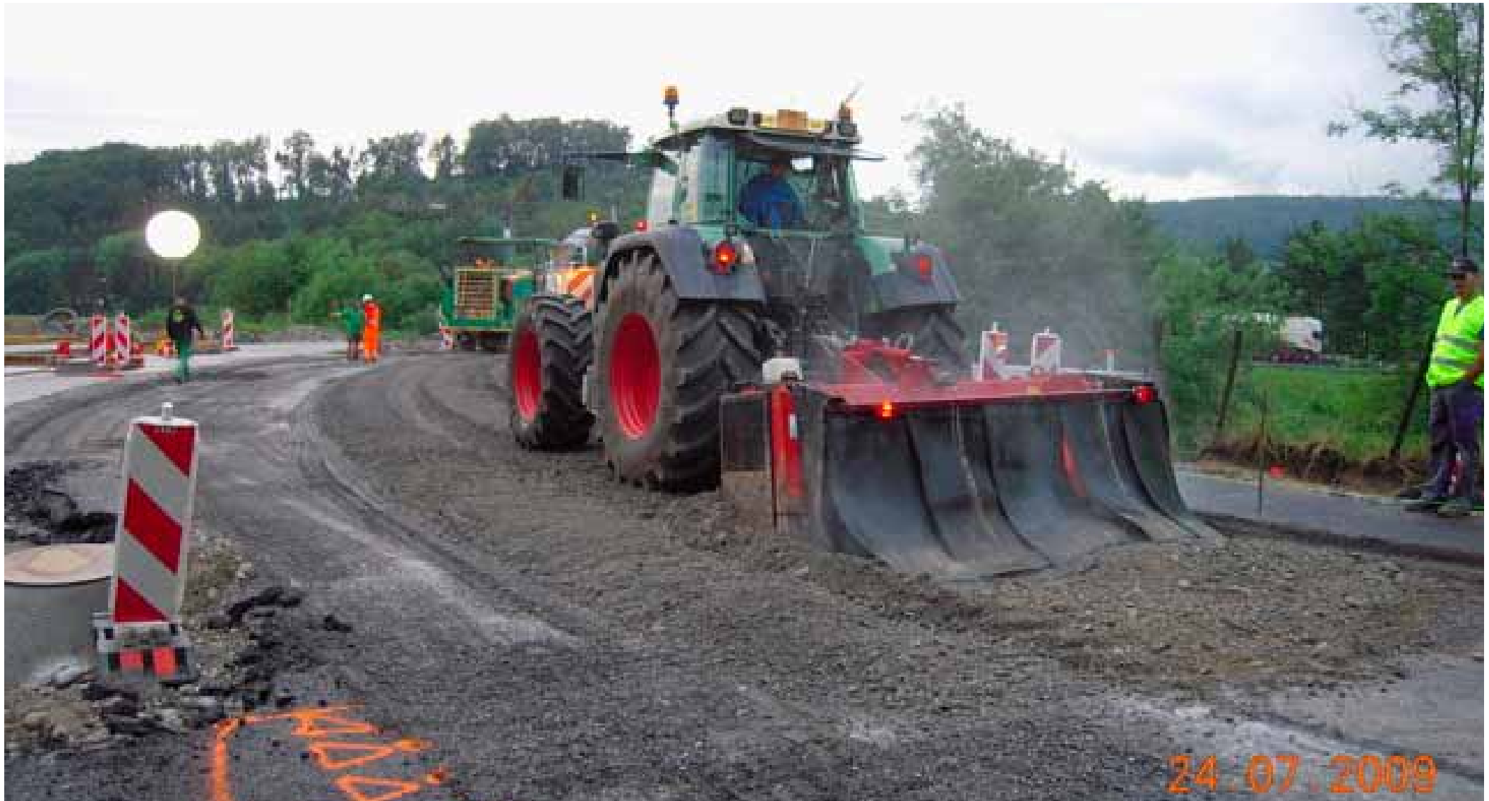
Einsatz der Steinfräse am 24.07.2009
