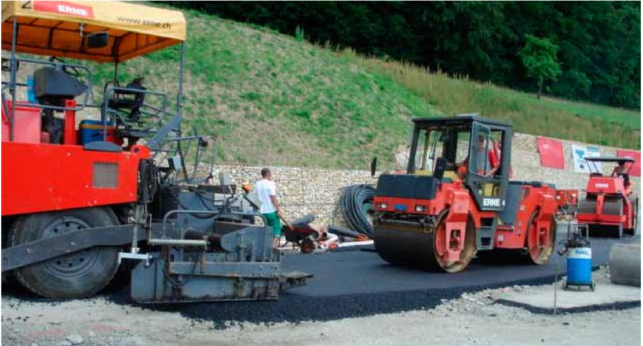
Einbau des neuen Asphaltbelages am 25.07.2009
