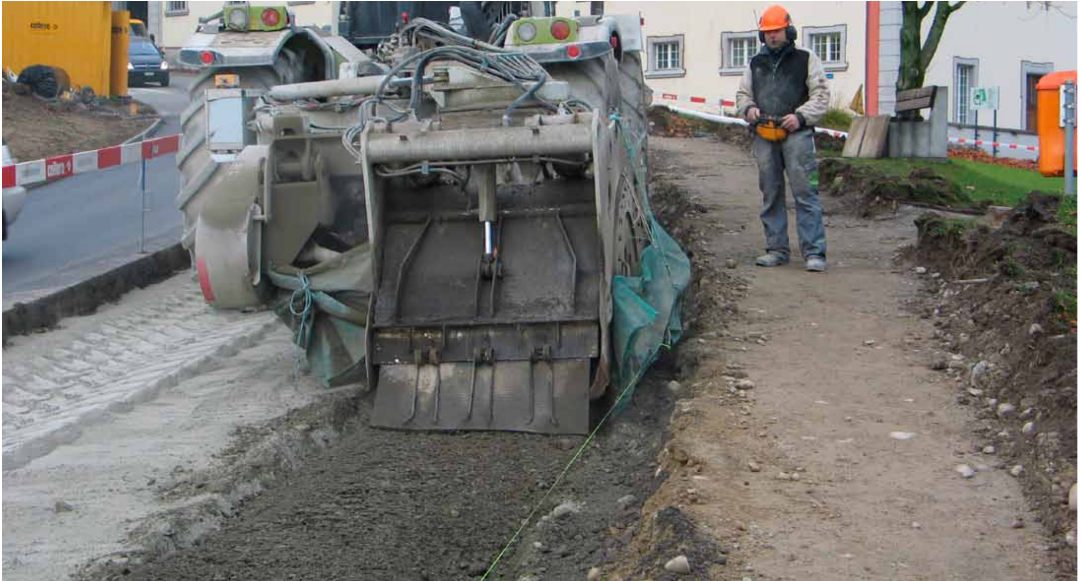
Einfräsen des Bindemittels
