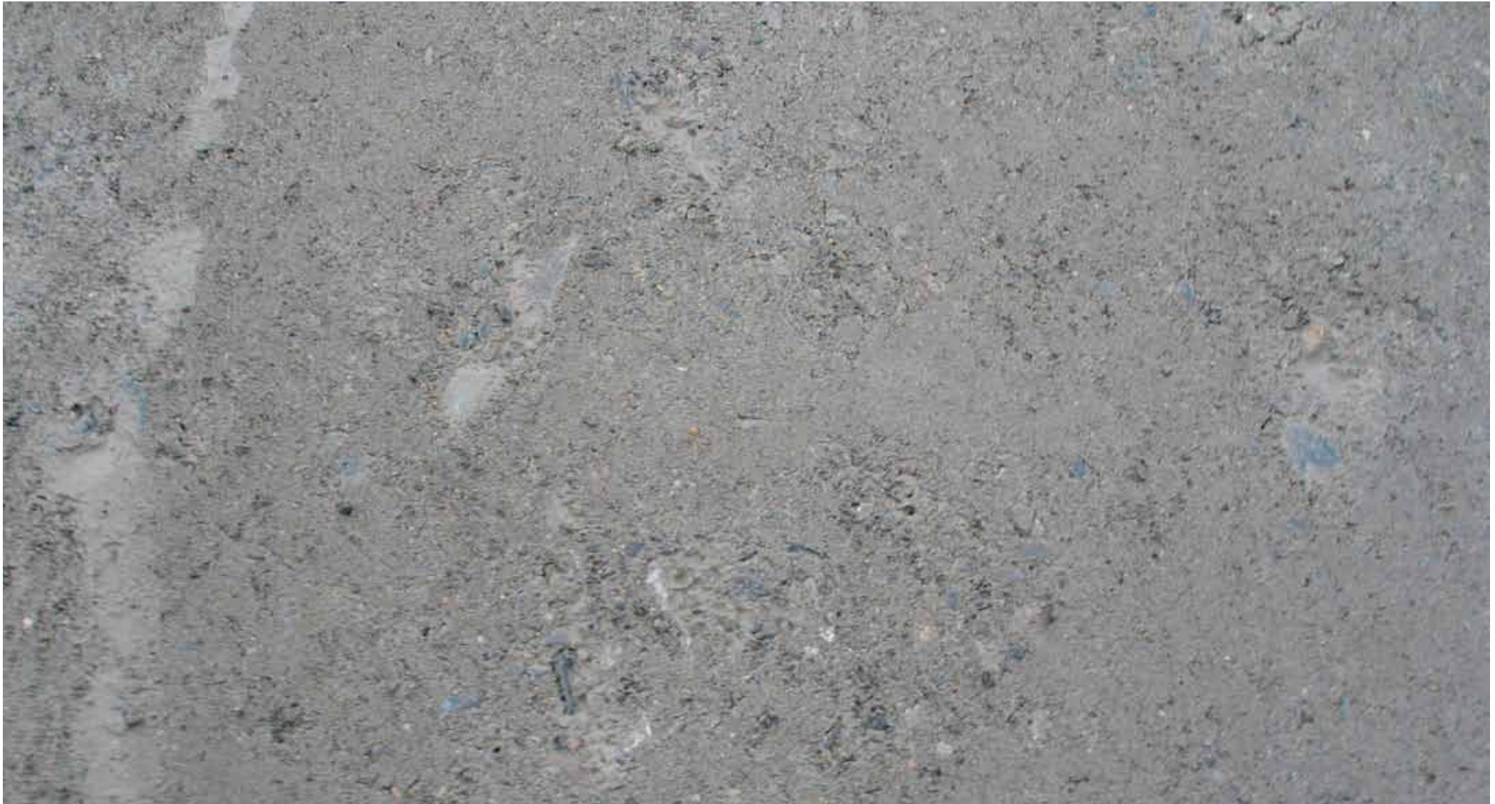
Fläche nach der Stabilisierung
