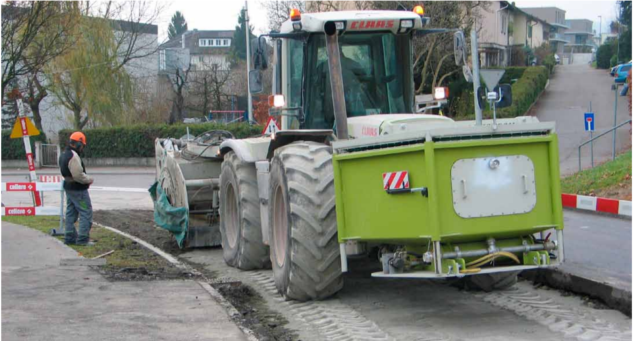
Einfräsen des Bindemittels
