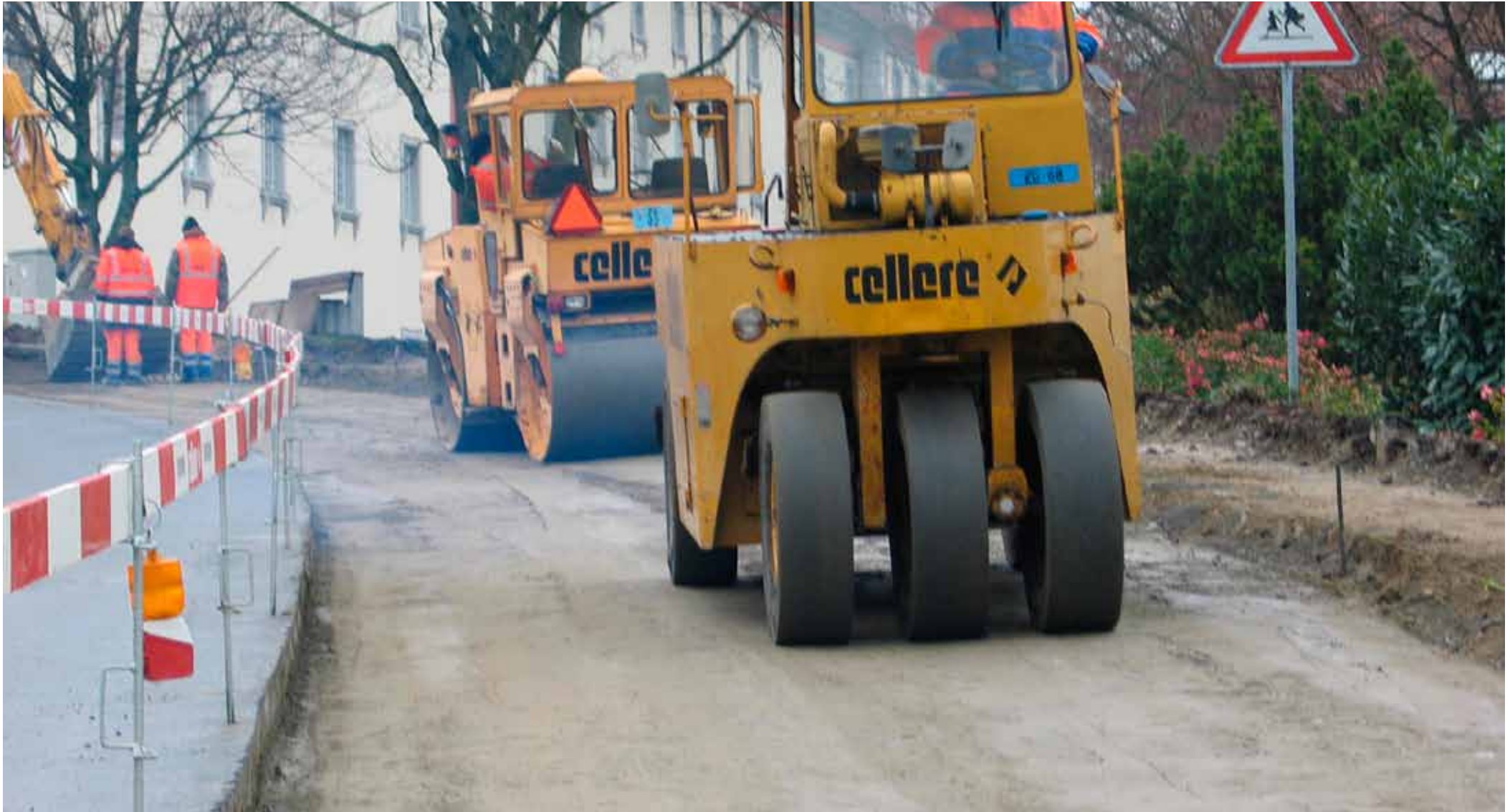
Verdichtung des Feinplanums
