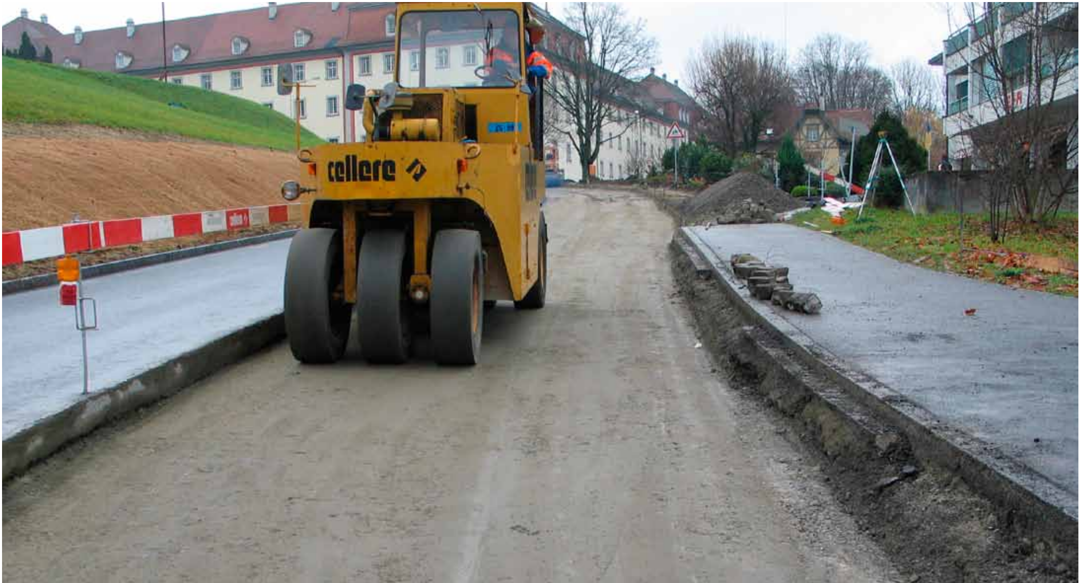
Verdichtung des Feinplanums
