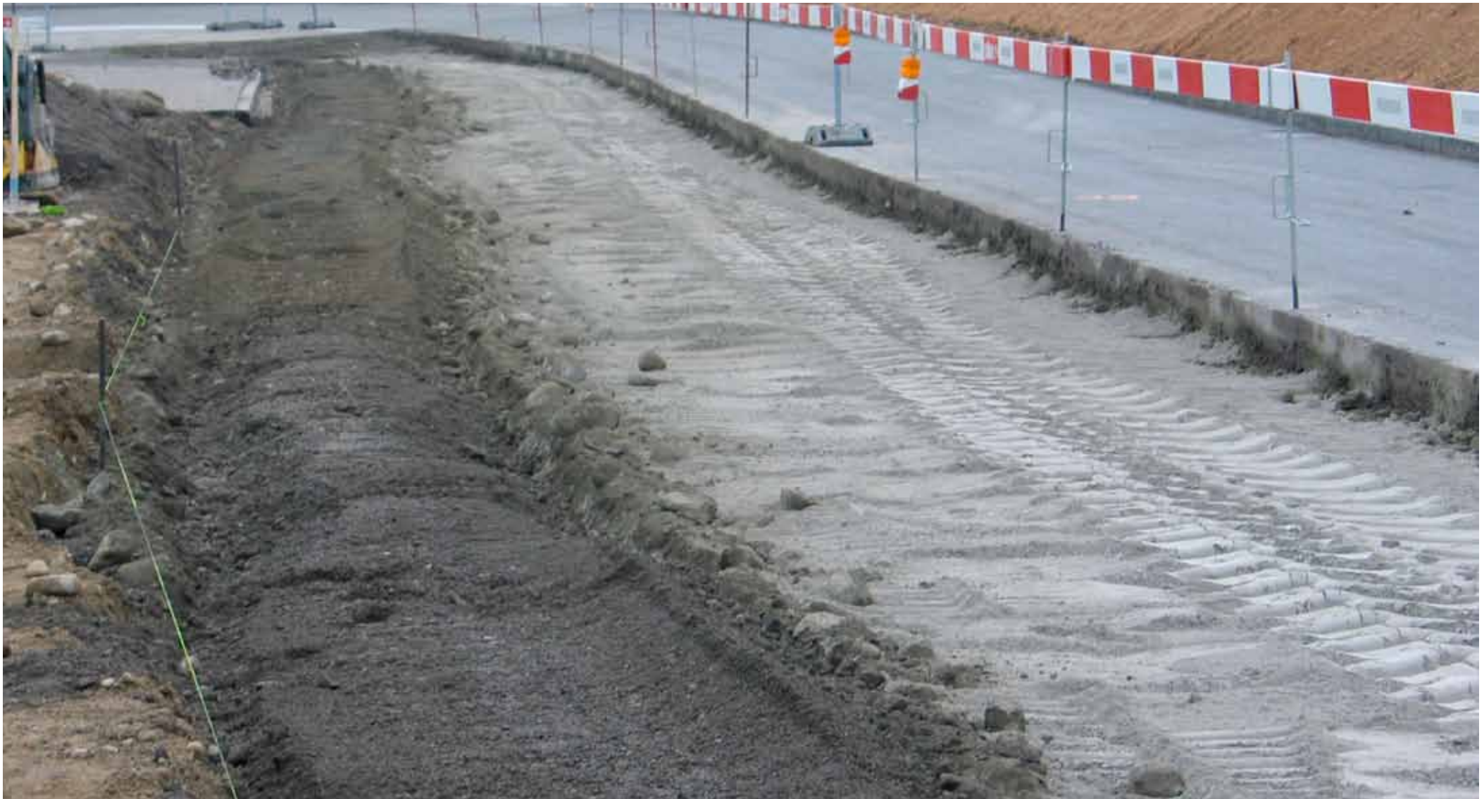
Fläche nach dem Fräsen
