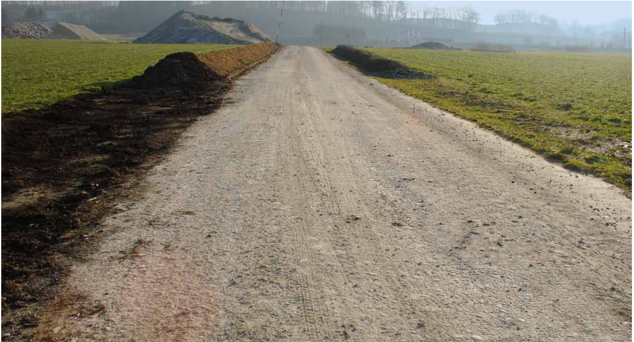
Fertige Fläche (ohne Schutz-/Verschleißschicht)
