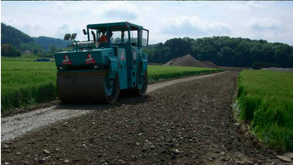
Nivellierung und Verdichtung der Feinplanie
