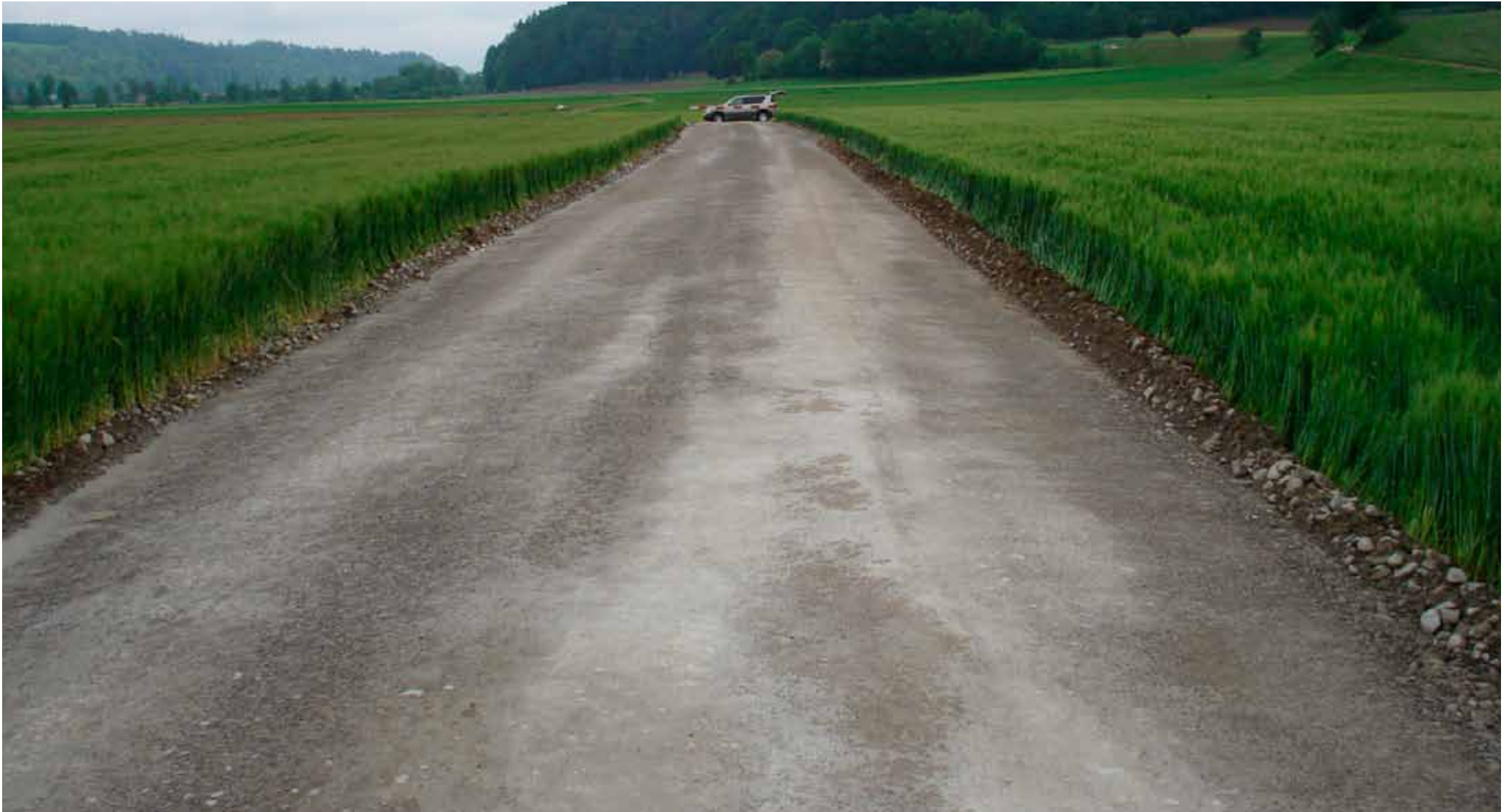
Fertige Fläche (ohne Schutz-/Verschleißschicht)
