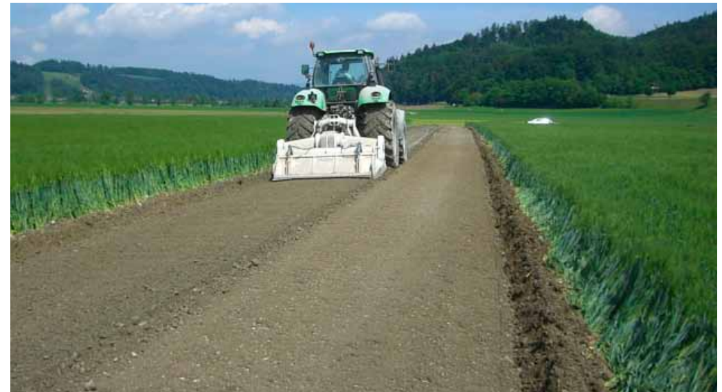
Einfräsen des Bindemittels
