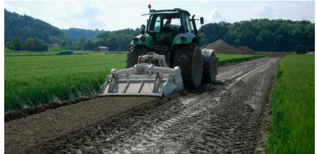
Einfräsen von Zement und NovoCrete® bis auf eine Tiefe von 40 cm
