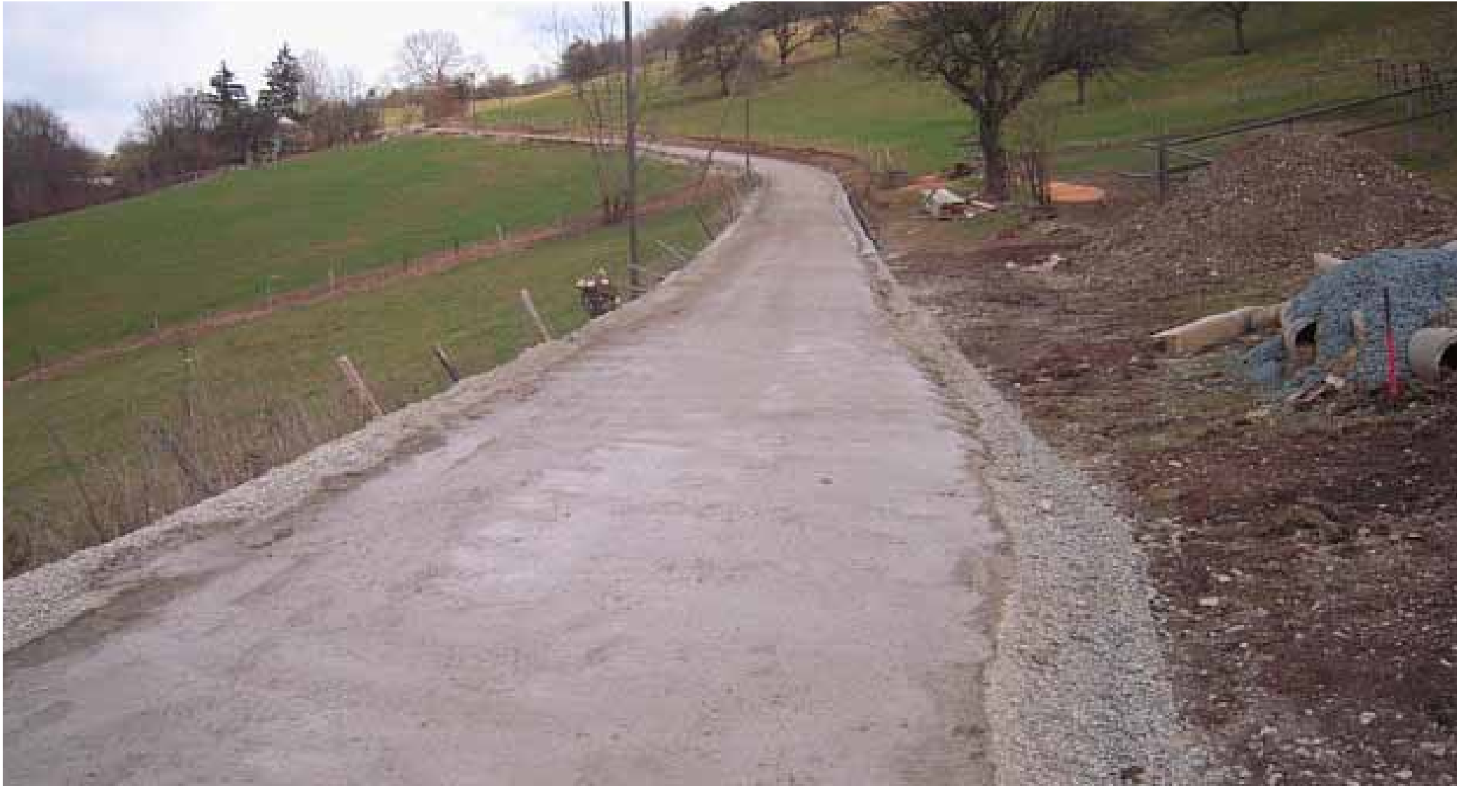
Fläche nach dem Verdichten und Wässern
