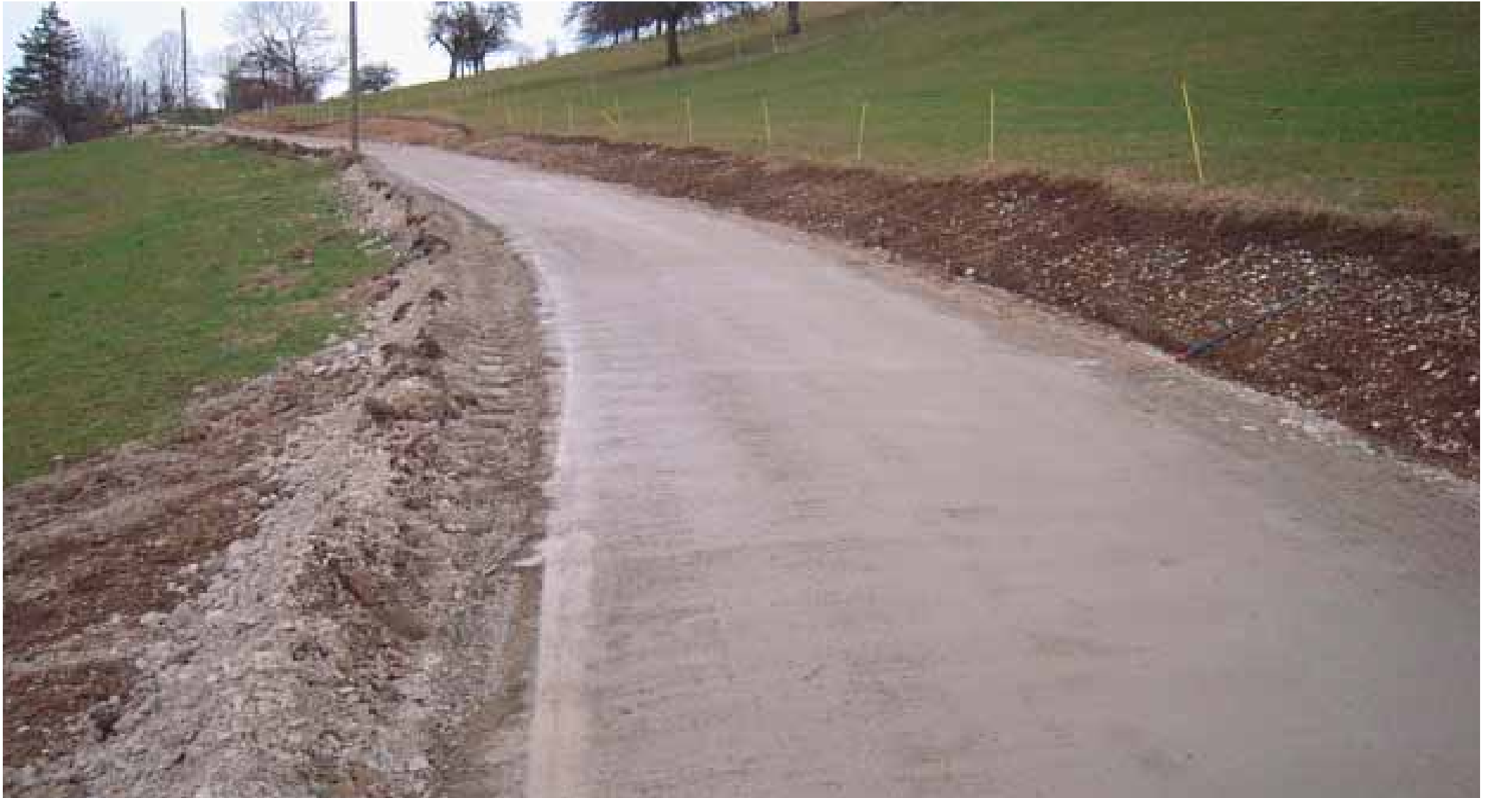
Fläche nach dem Verdichten und Wässern
