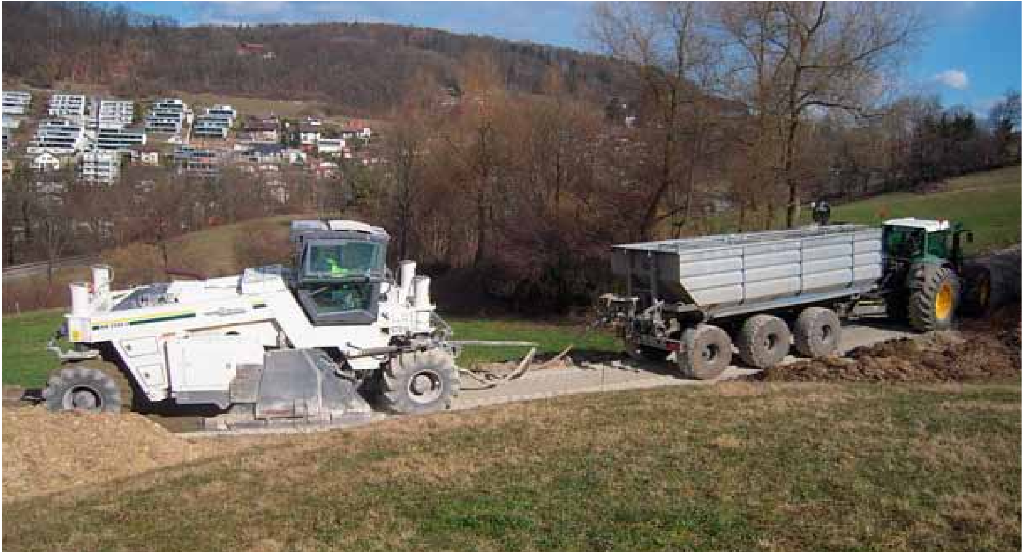
Einfräsen des Bindemittels mit der WR 2500
