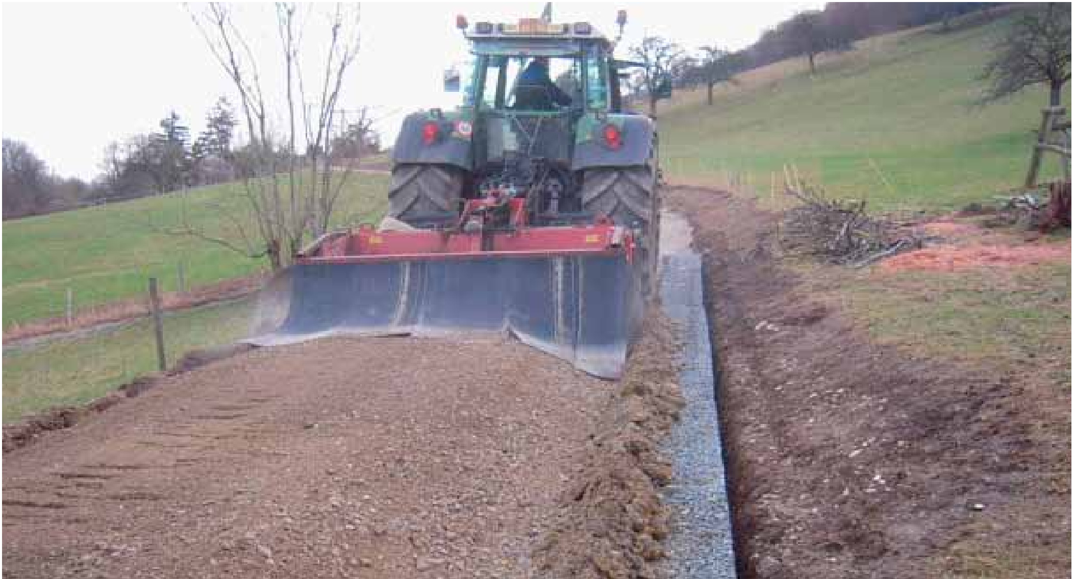
Einsatz der Steinfräse
