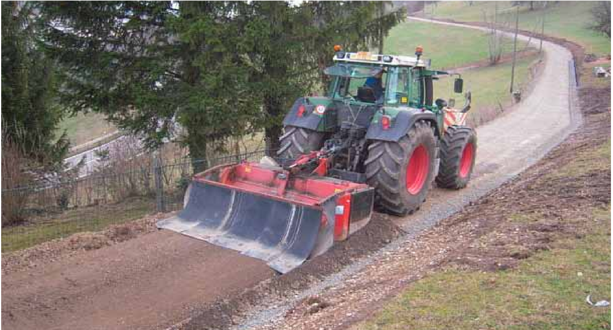
Einsatz der Steinfräse
