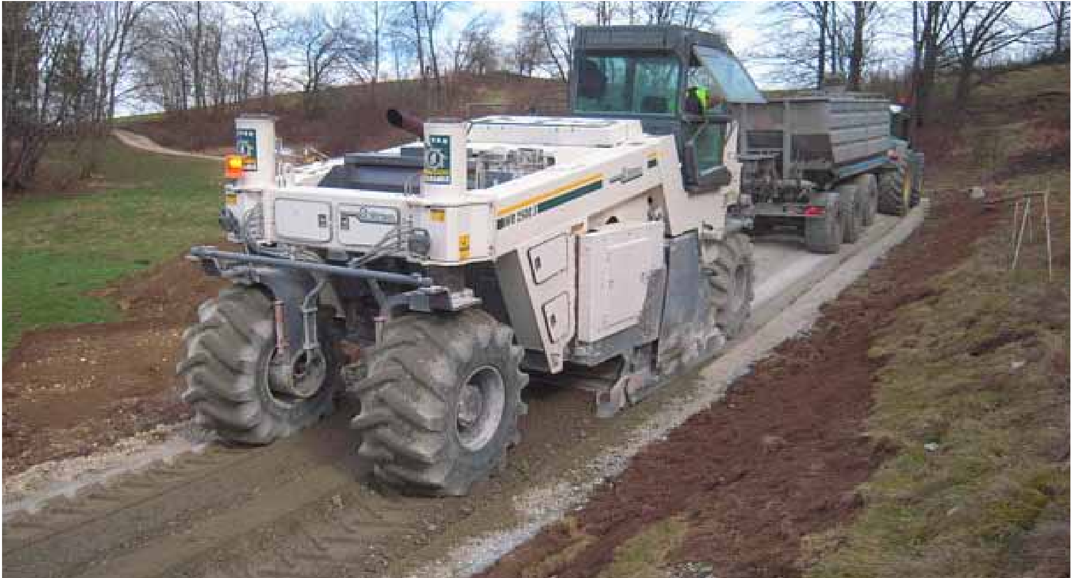
Einfräsen des Bindemittels mit der WR 2500
