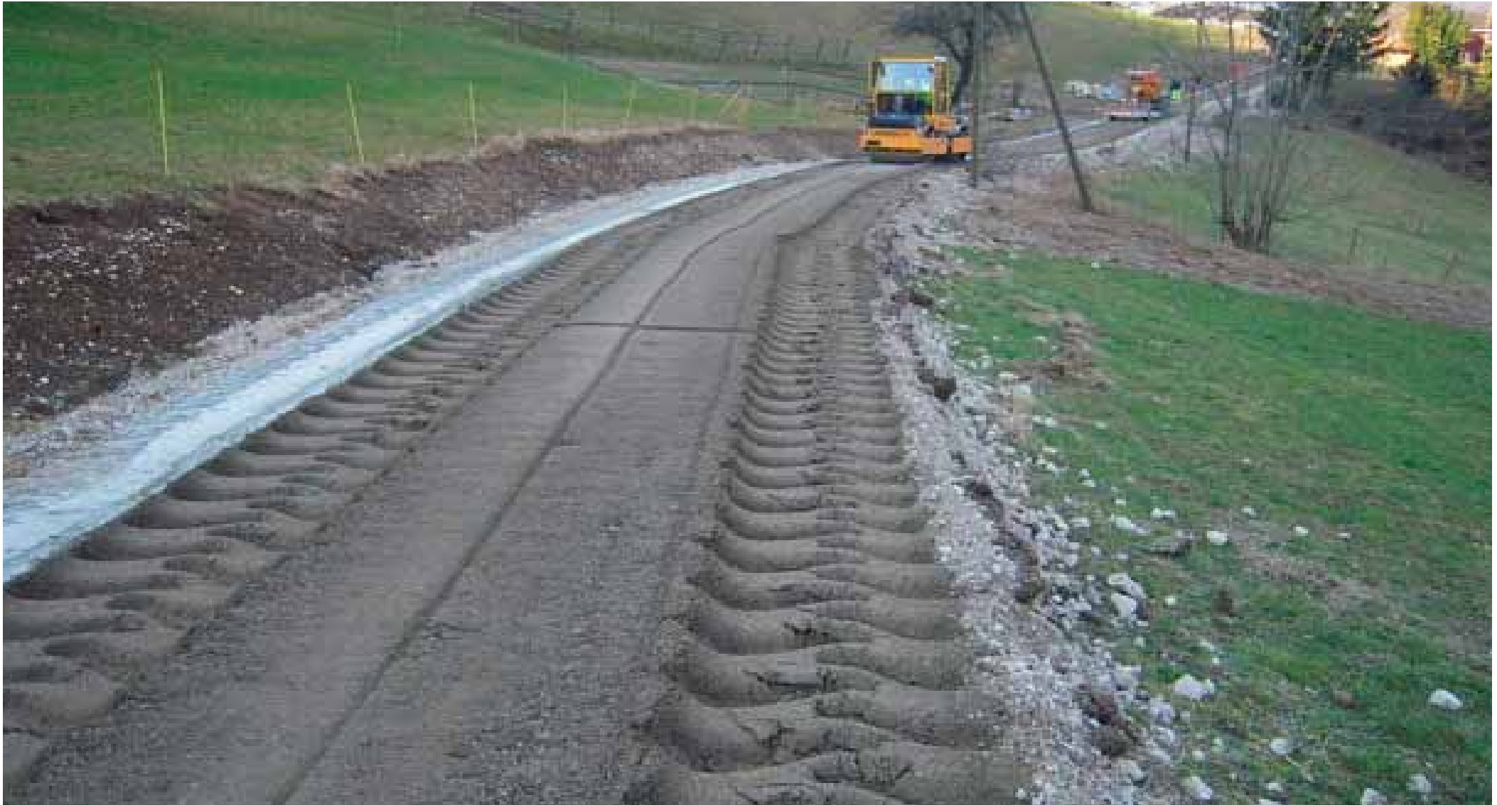
Situation nach dem Fräsvorgang
