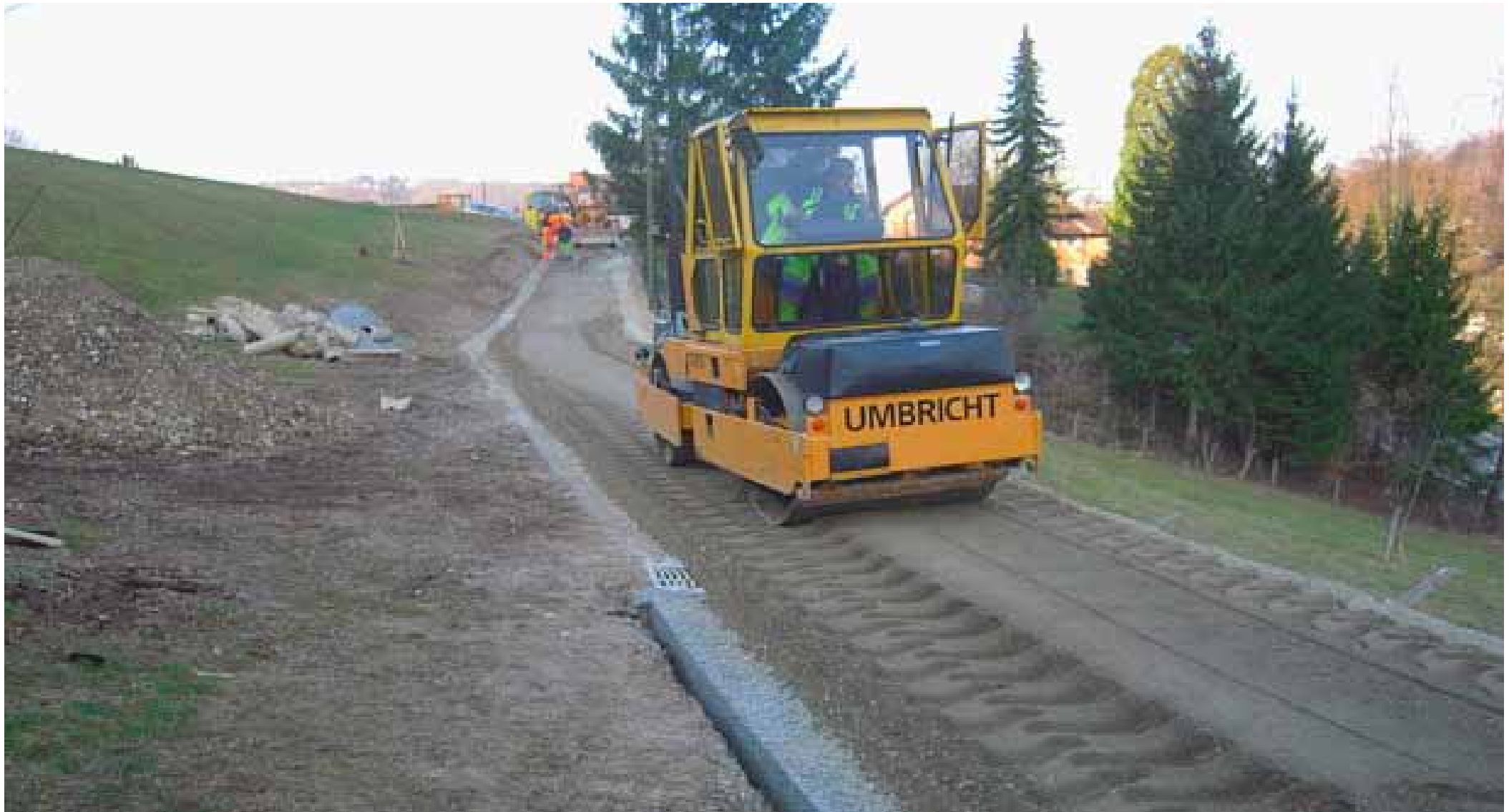
Verdichtung mit Glattmantelwalze
