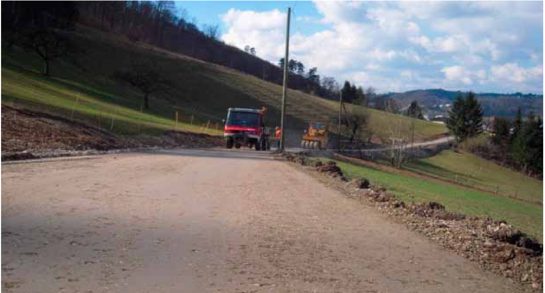
Fläche nach der Verdichtung
