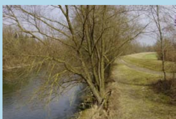
Reusdammsanierung, Sinsler- / Mühlauerbrücke
