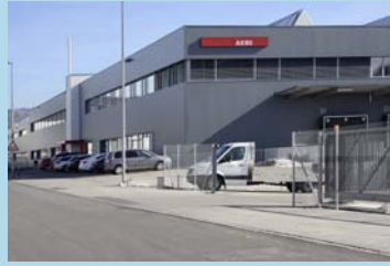
AEBI Werkhalle, Burgdorf
