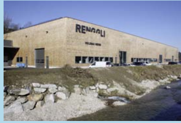
Neue Werkhalle Renggli Holzbau, Gläng Schötz
