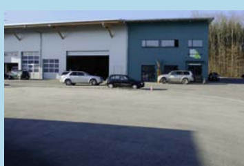
Werkhalle Holztrans AG, Hunzenschwil
