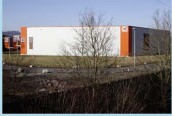
Müller Logistikzentrale, Oberentfelden
